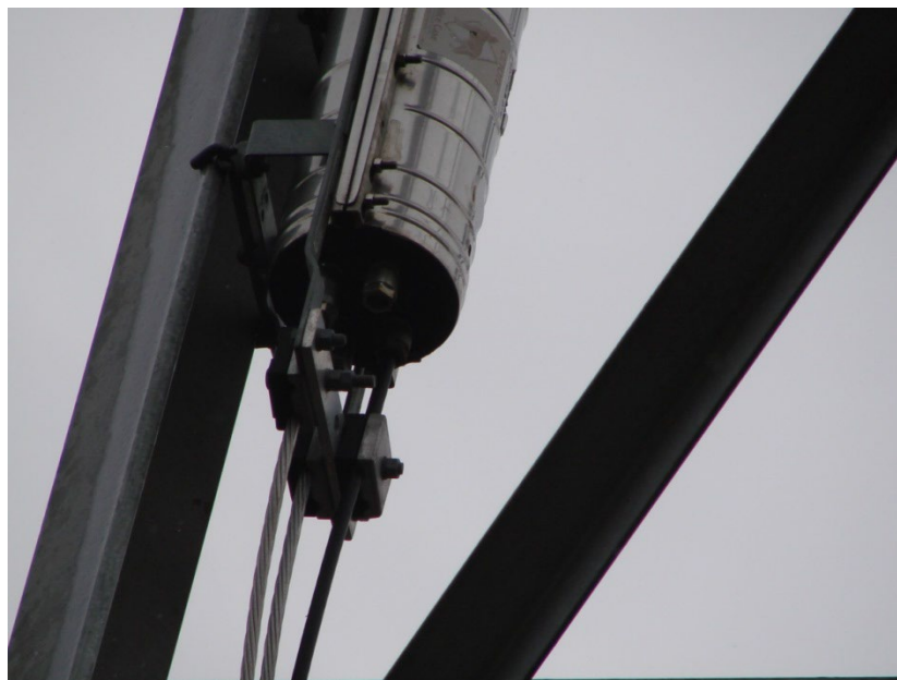
Figure 93: OPGW Splice Pod
