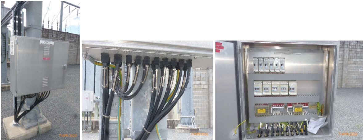
(d) 3 Bus 8 VT Marshalling Kiosk (+KD3-A10)
